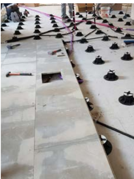
Disposizione giunti al di sotto di porte battenti.
