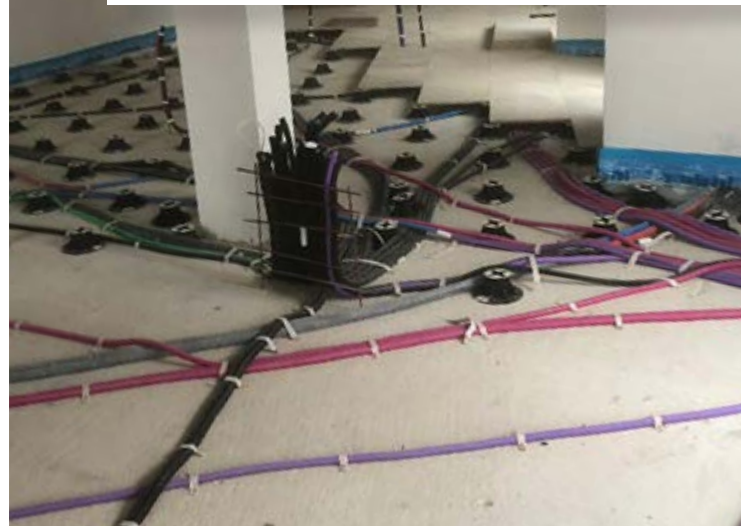
Esempio del passaggio degli impianti sotto il sistema radiante sopraelevato Betonradiant®
